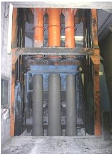
Fabrication des tuyaux en béton
